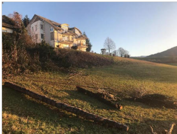
Standort im Norden – Blick Richtung Südosten
