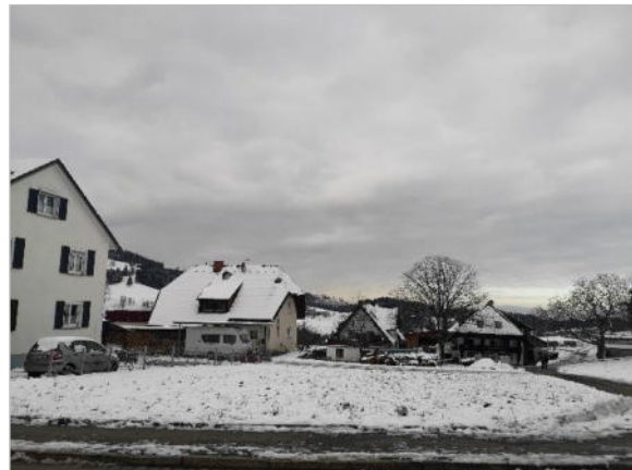
Standort im Osten – Blick Richtung Westen
