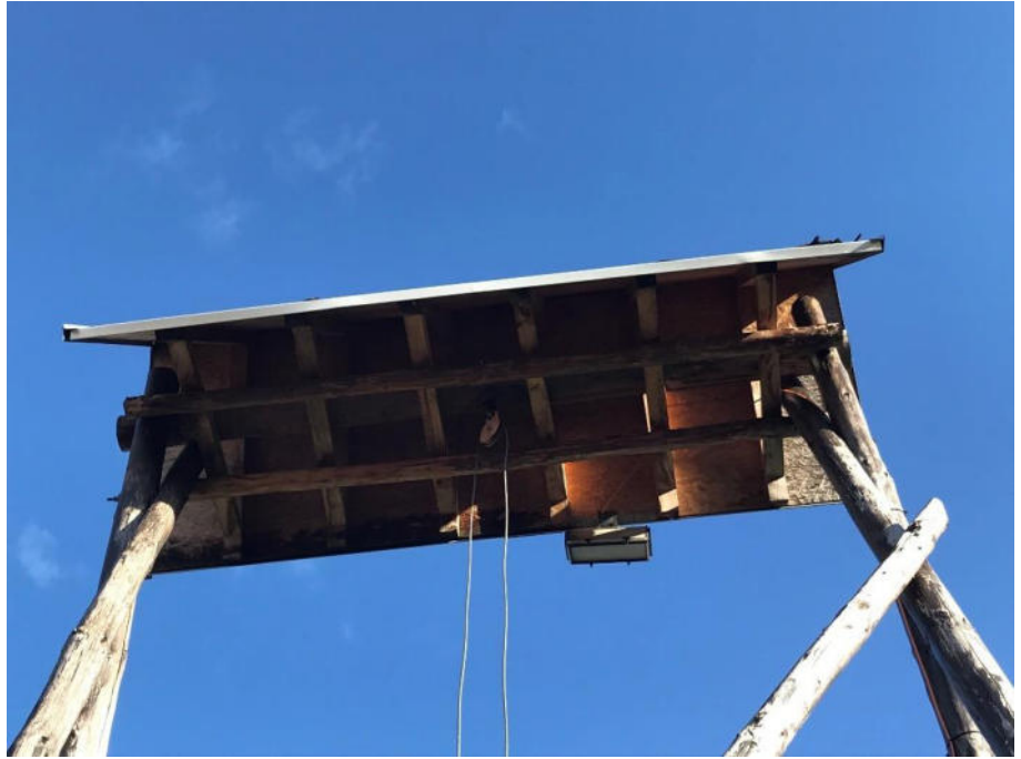
Foto 5: Der Turm der Tauziehanlage
