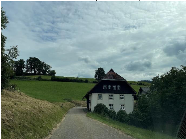
Abbildung 6: Bebauung Bühlhofweg (eigene Aufnahme, 2023)
