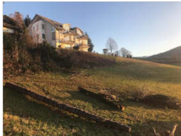
Standort im Norden – Blick Richtung Südosten
