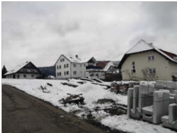
Standort im Nordwesten – Blick Richtung Südosten
