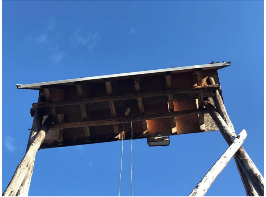
Foto 5: Der Turm der Tauziehanlage
