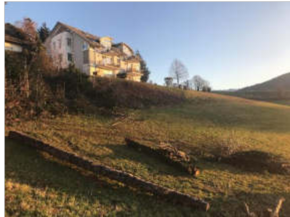
Standort im Norden – Blick Richtung Südosten
