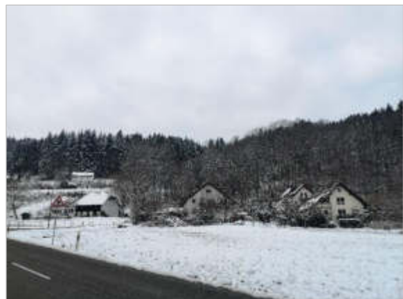
Standort im Osten – Blick Richtung Nordwesten
