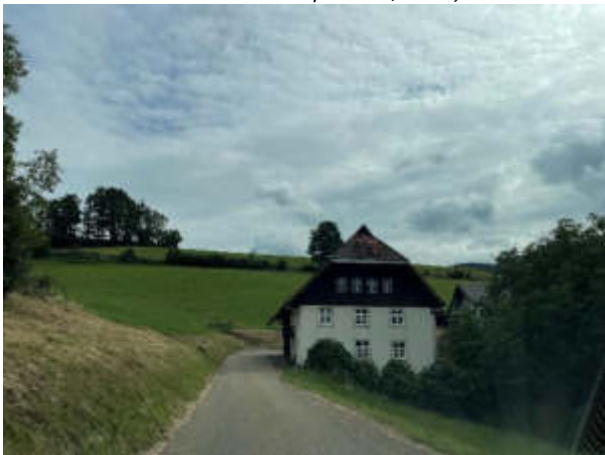
Abbildung 6: Bebauung Bühlhofweg (eigene Aufnahme, 2023)
