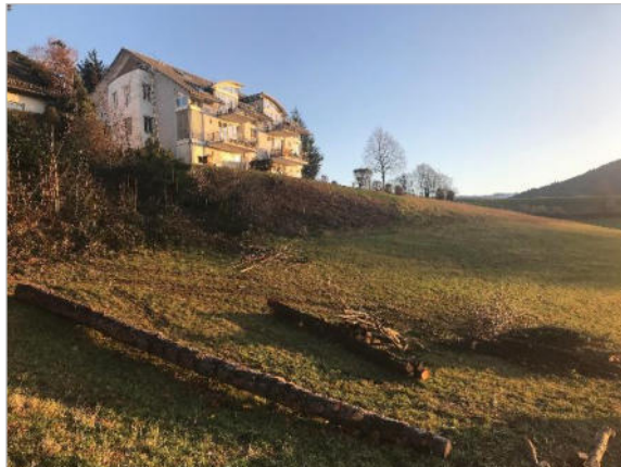
Standort im Norden – Blick Richtung Südosten
